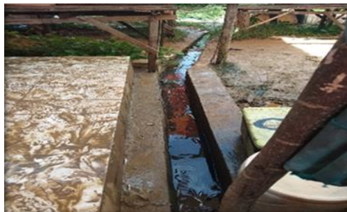
Gambar 3. Saluran Limbah/ Drainase (Sumber: Dokumentasi Pribadi)
